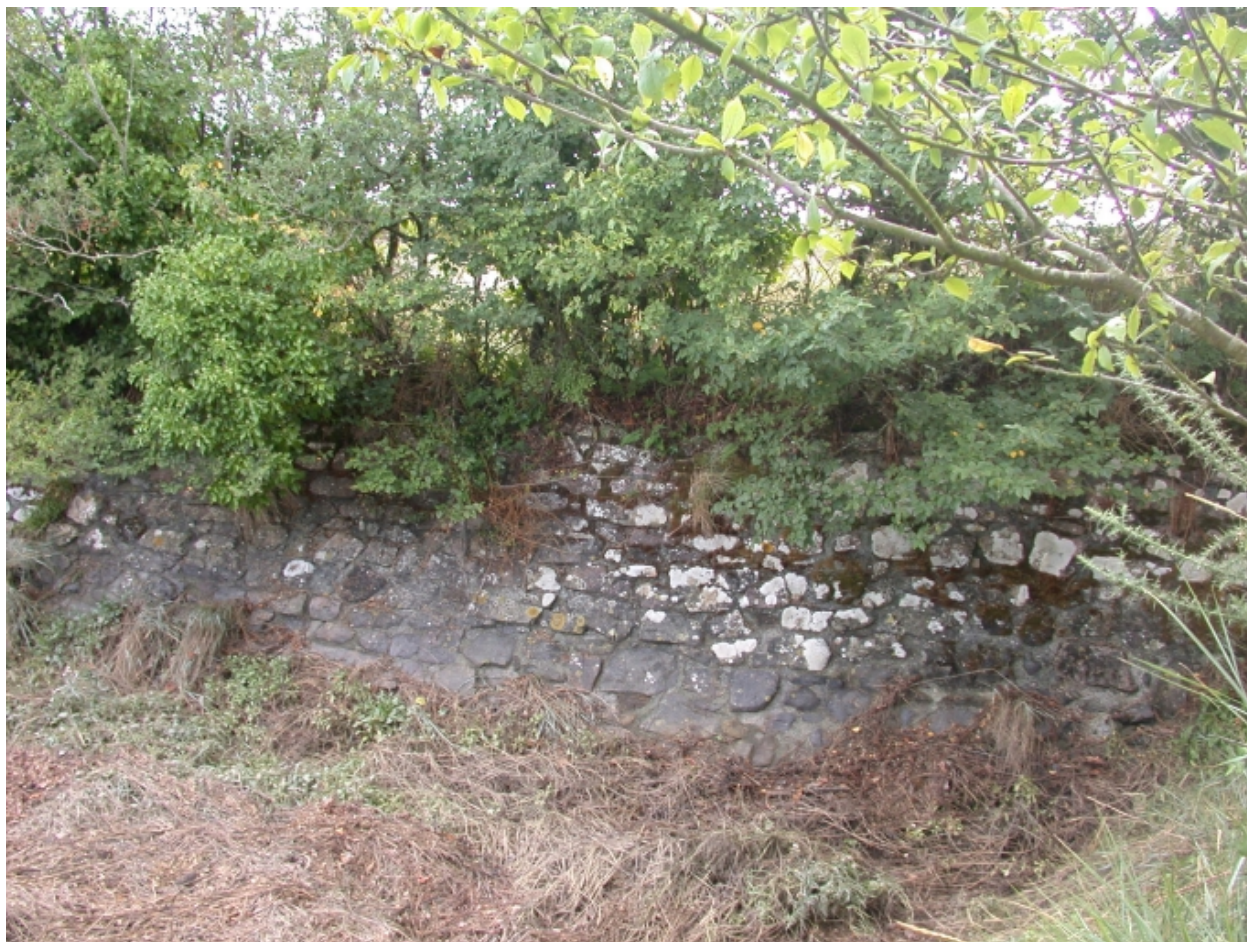
Vue de détail du mur de quai en sousbassement du sentier de Cruckin
