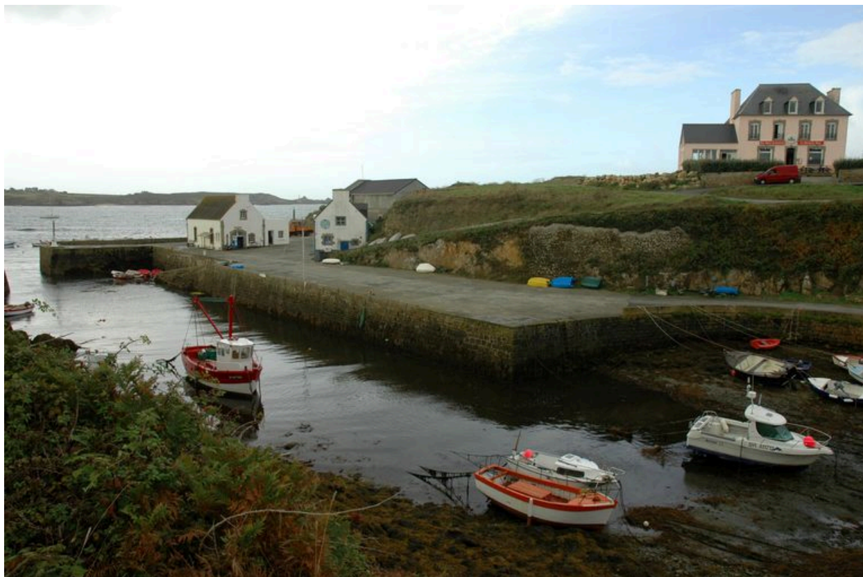
Vue du port-abri de Lampaul
