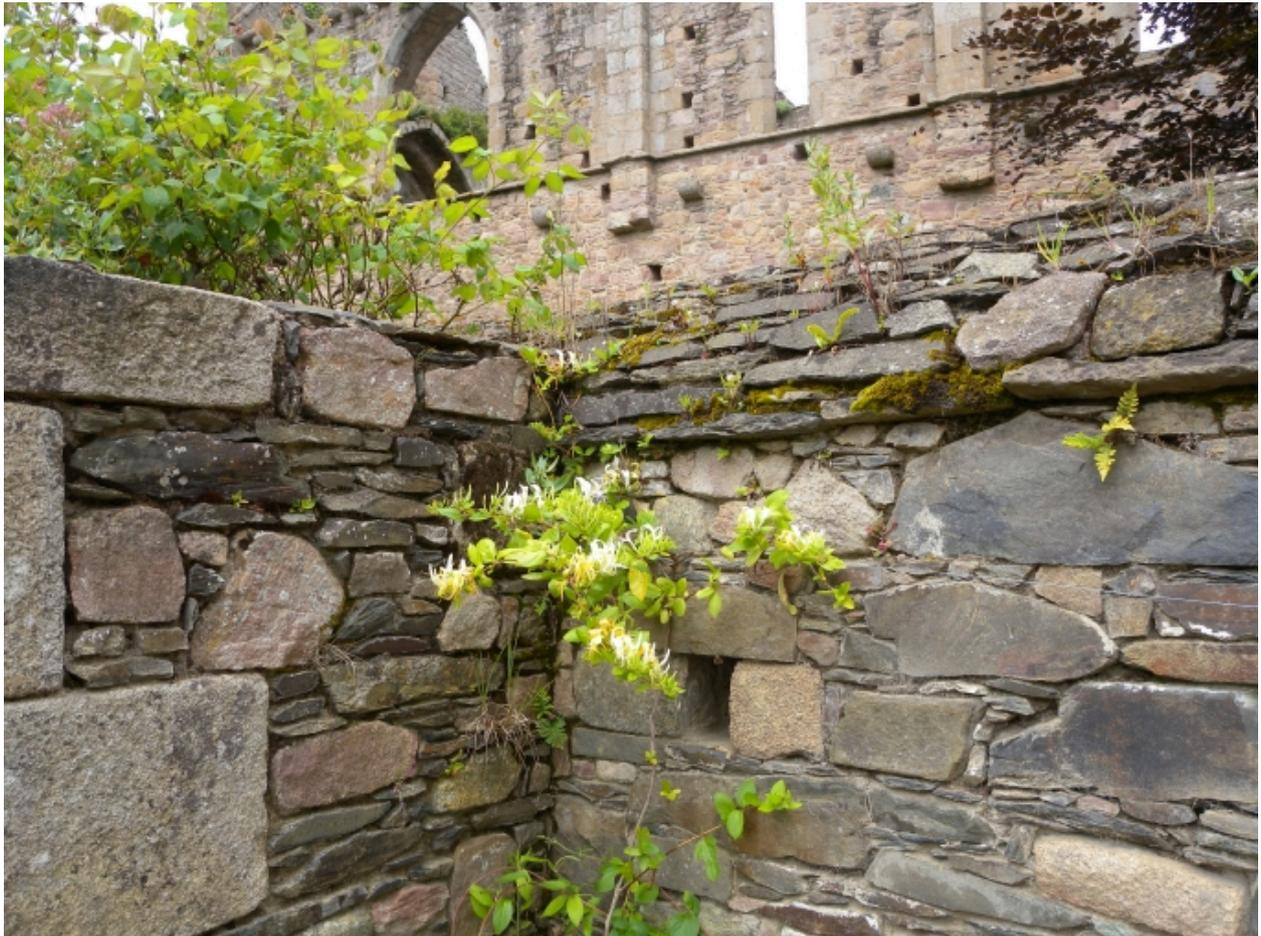
Vue de détail d'un angle du mur d'enceinte Nord, restauré, construit en moellons de schiste et pierre de taille
