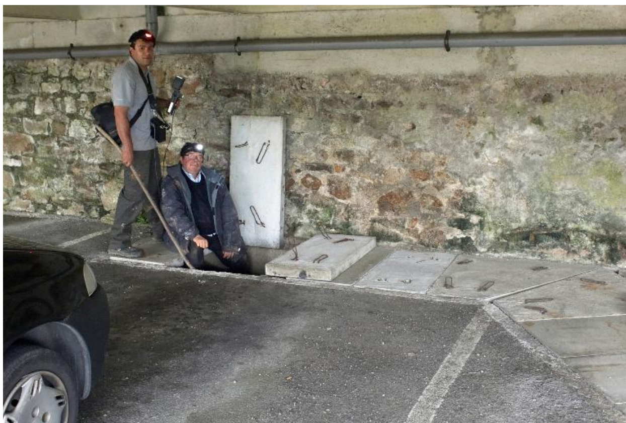
Vue de l'entrée (état en 2009)
