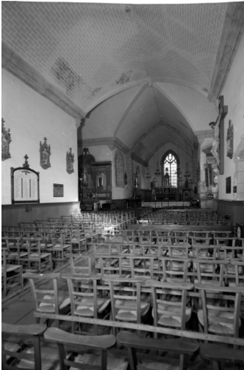
Intérieur, vue générale d'ouest en est.
