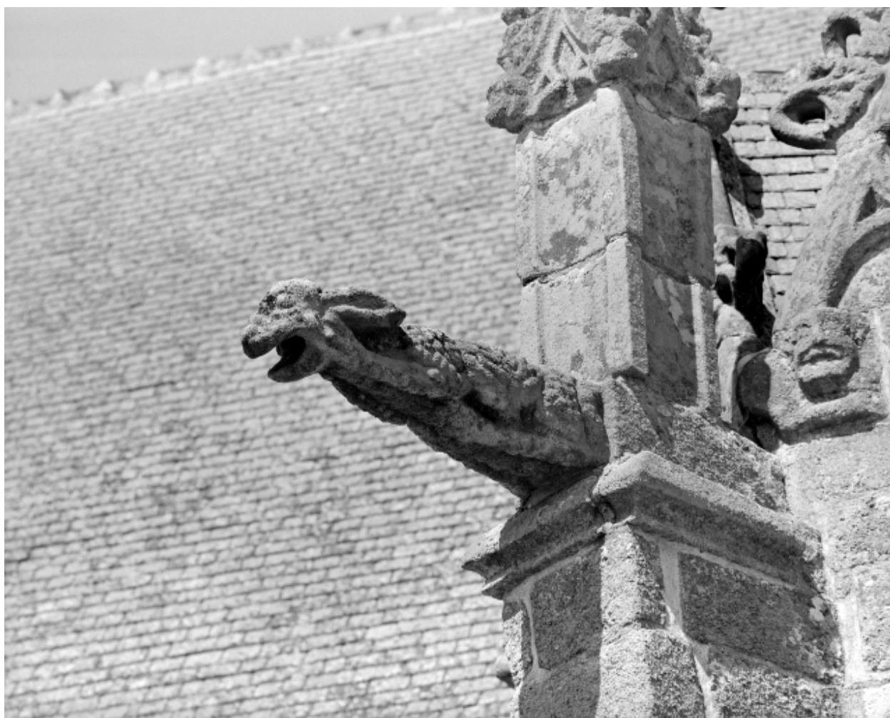
Elévation sud, vue de détail de gargouille.
