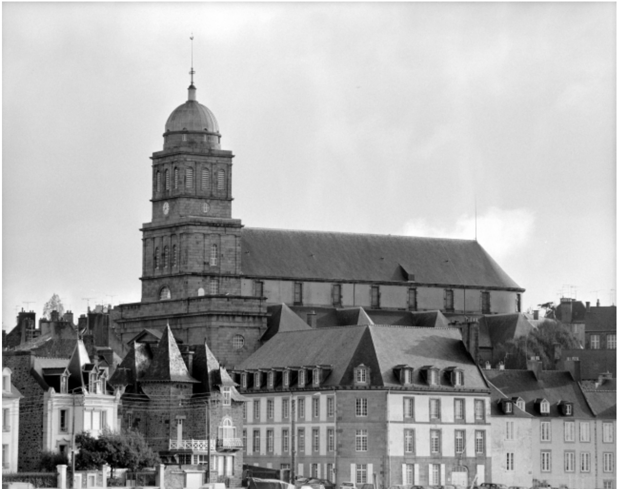
Elévation Ouest : vue générale
