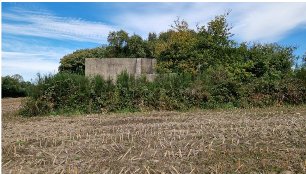
Vue générale : élévation sud
