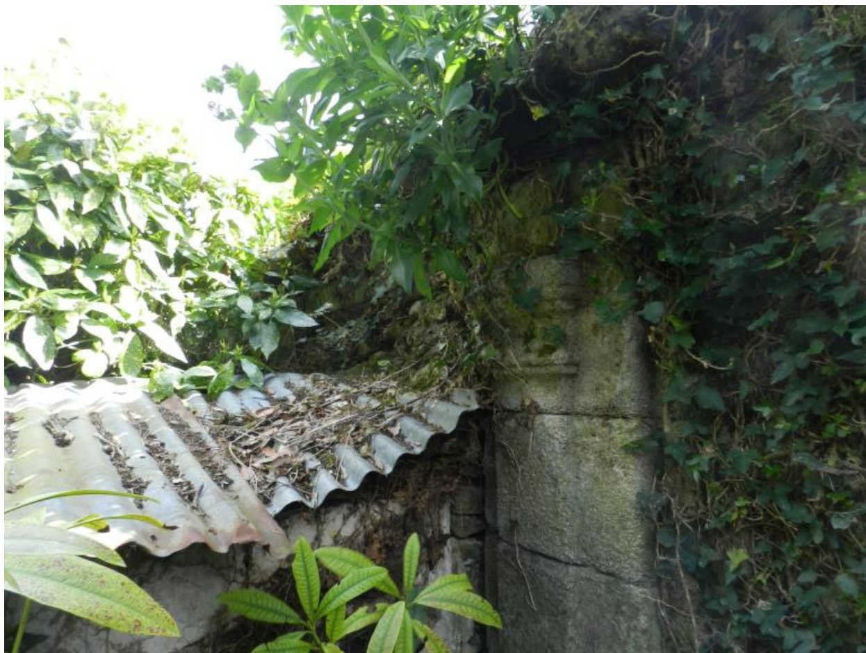
Porte du vicaier, partie haute du pilastre. On distingue le toit de tôle qui couvre l'édicule construit devant.
