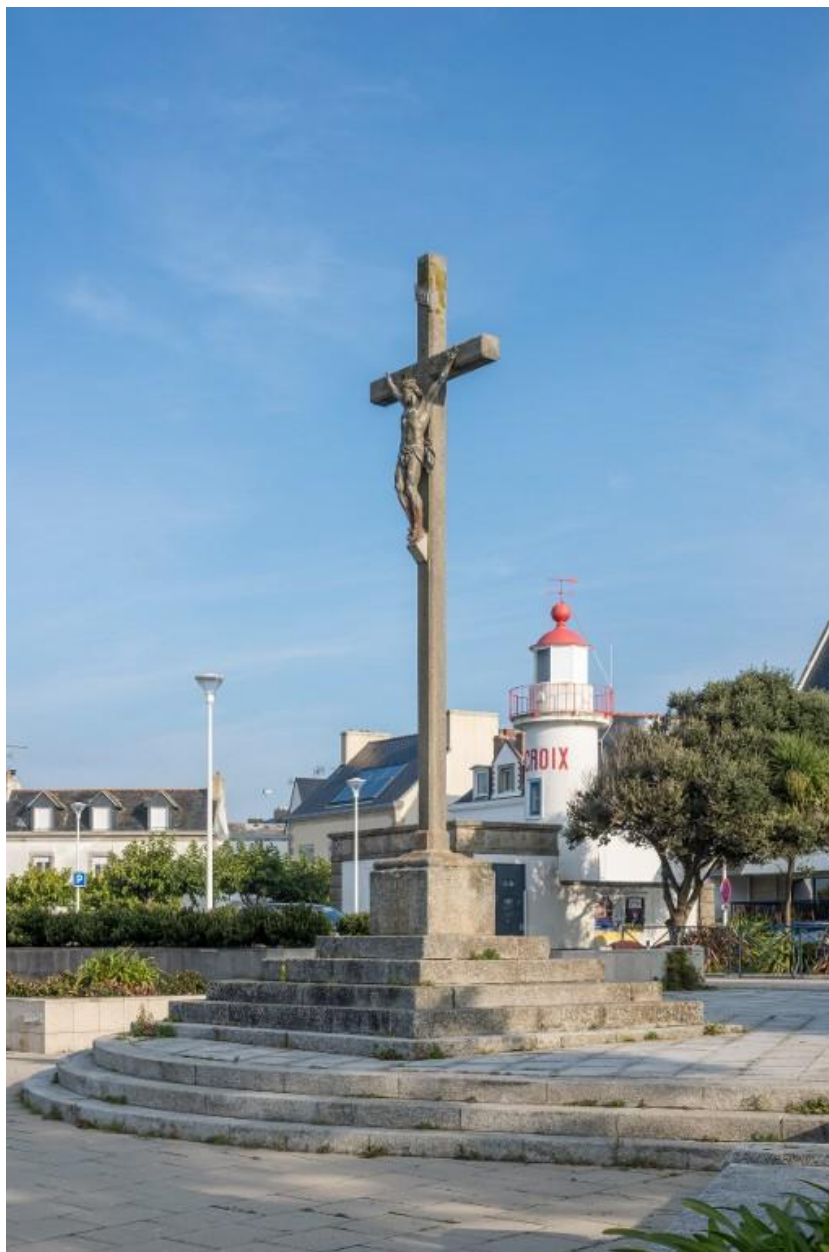
Croix n°2 érigée en ciment restaurée en 1925 avec un Christ en fonte, sur socle cubique
