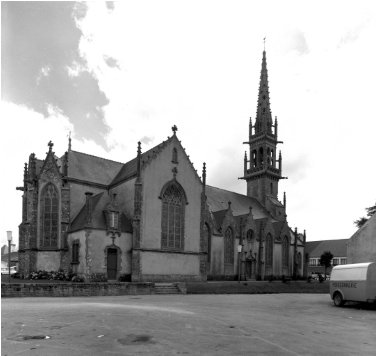
Plonévez-Porzay, église paroissiale Saint-Milliau : vue générale sud, état en 1970
