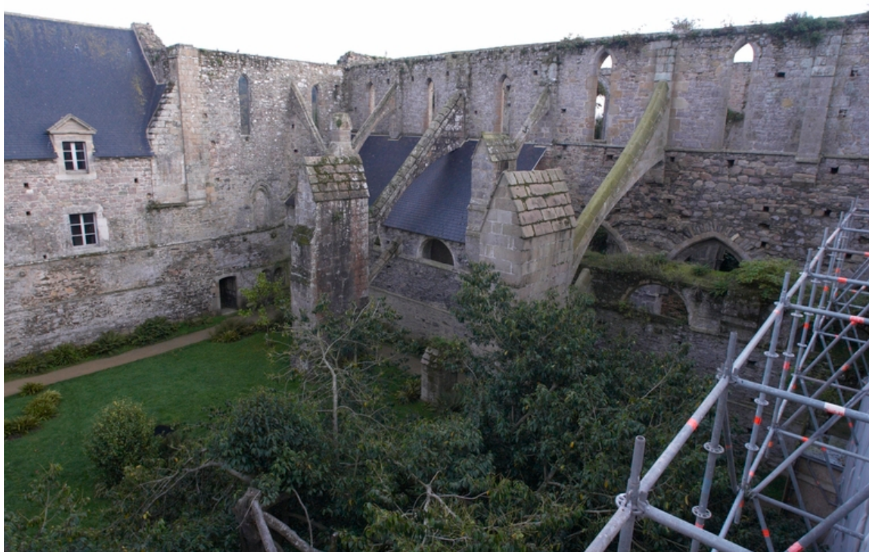
Vue vers le sud du cloître
