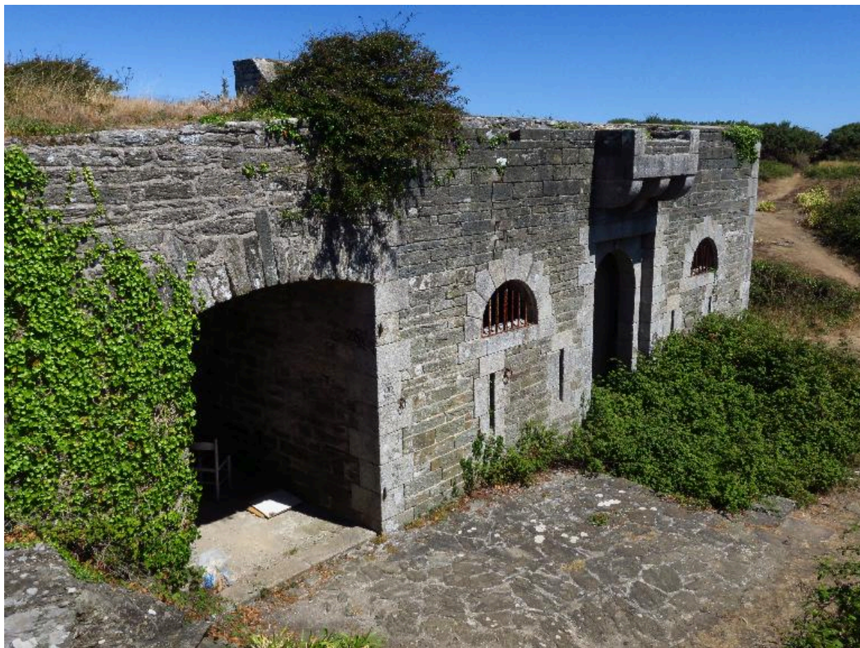
Groix, batterie du Bas-Grognon, corps de garde crénelé, façade.
