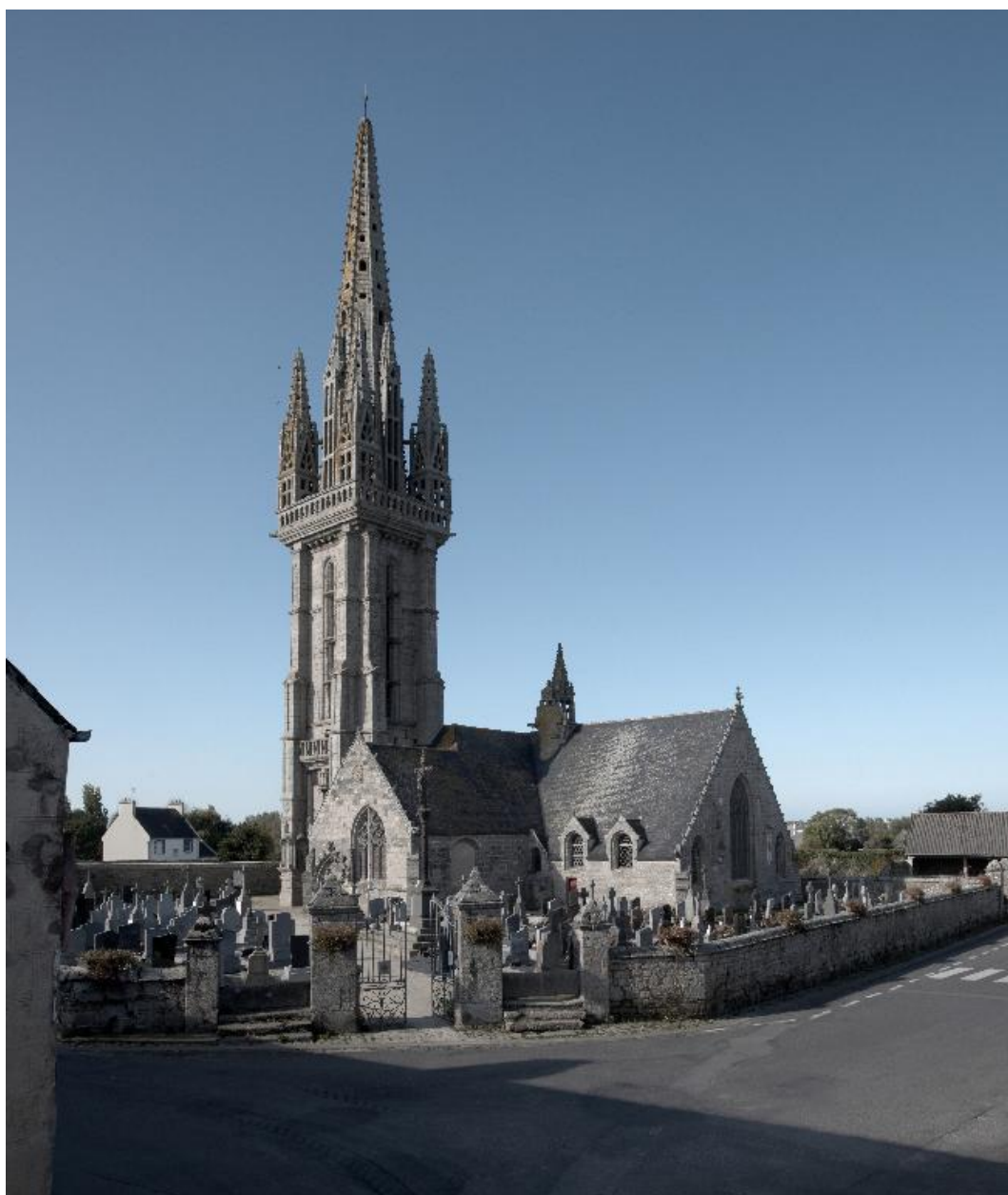
Vue générale sud-est de l'église
