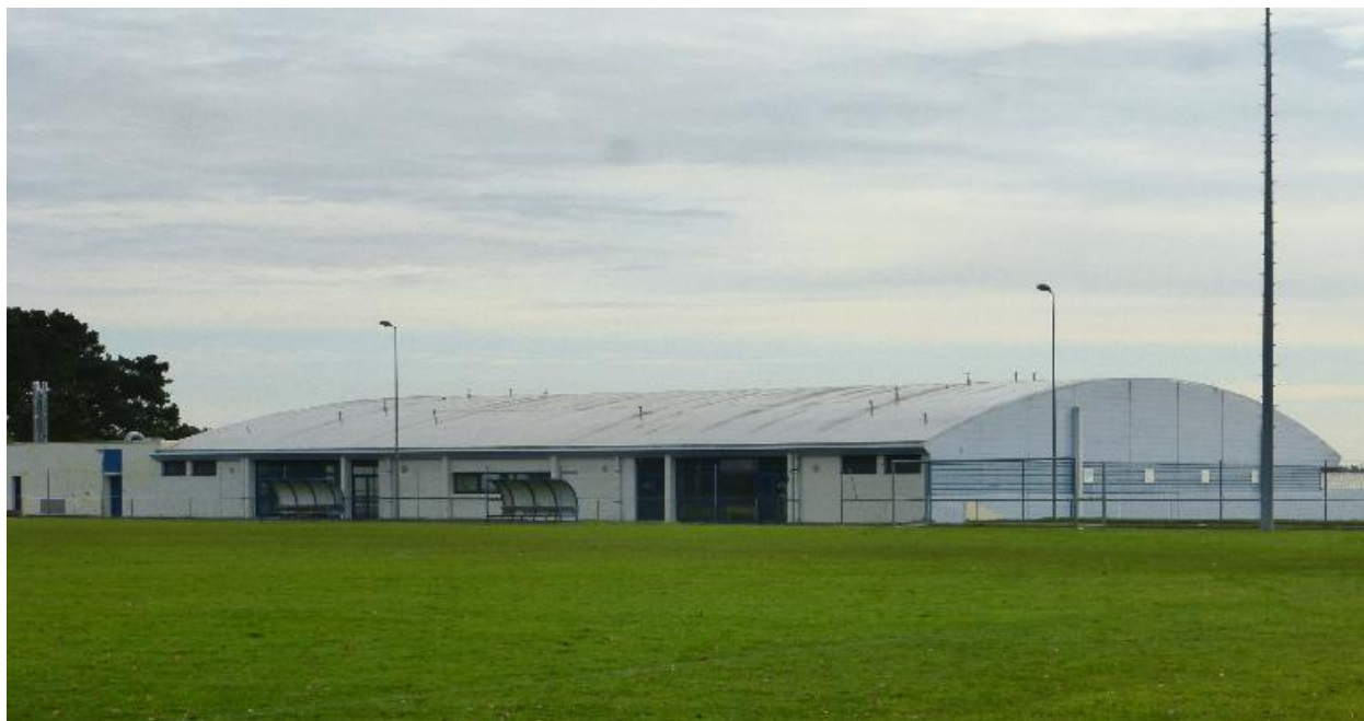
Vue générale prise du nord-ouest
