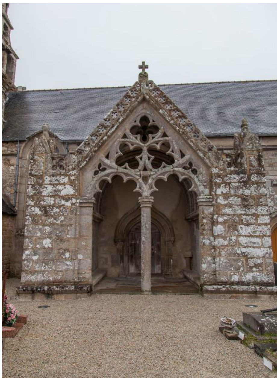
Porche méridional, Commanderie du Palacret, église paroissiale, Saint-Laurent
