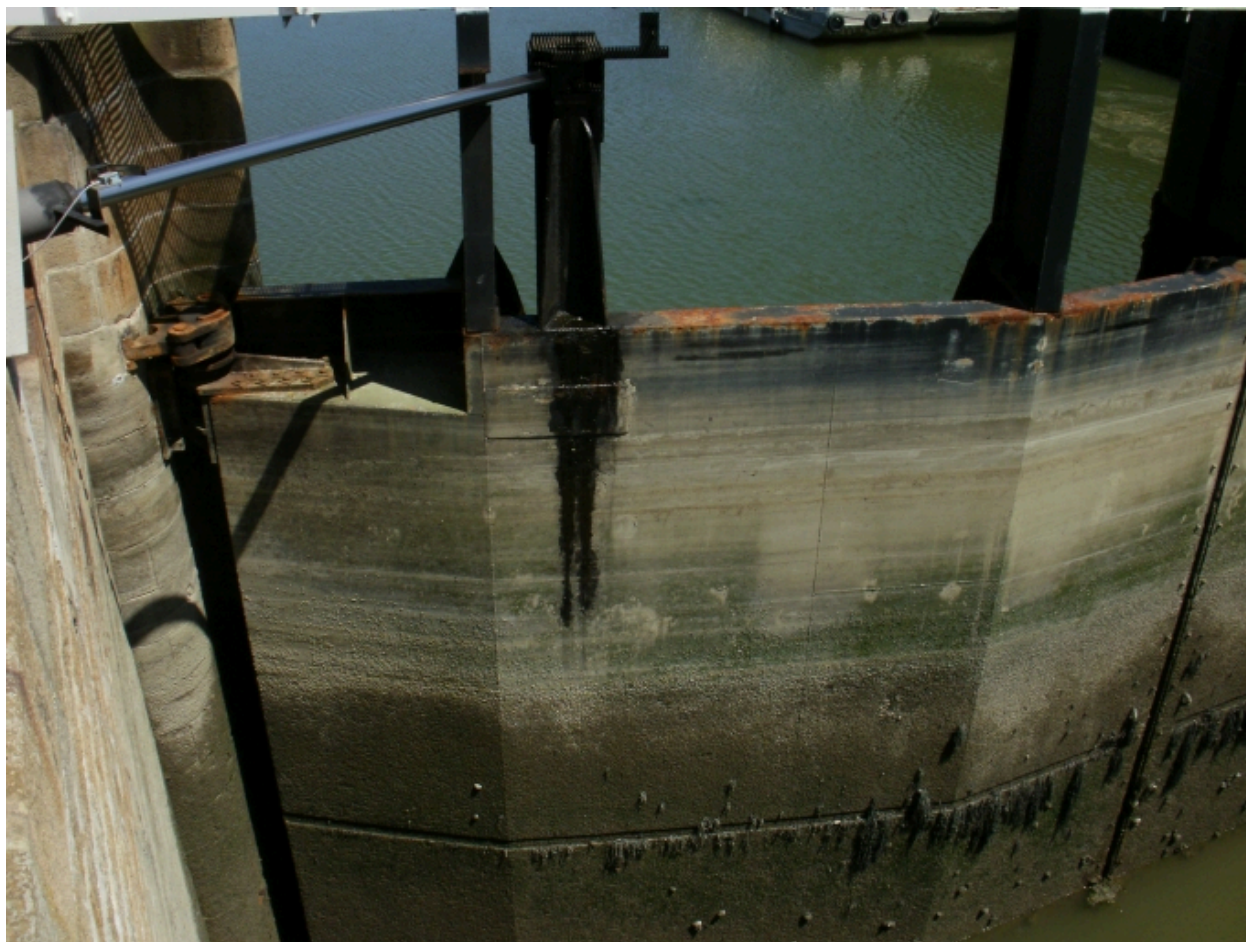
Vue de détail des portes métalliques et de la crémaillère
