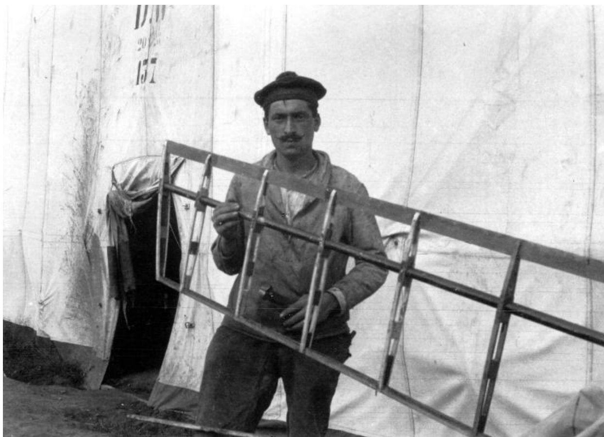
Charpentier de l'atelier aéronautique au travail : il porte une structure d'aileron (collection Daniel Dahiot - Archives départementales du Finistère, FRAD029_1NUM_007_60)
