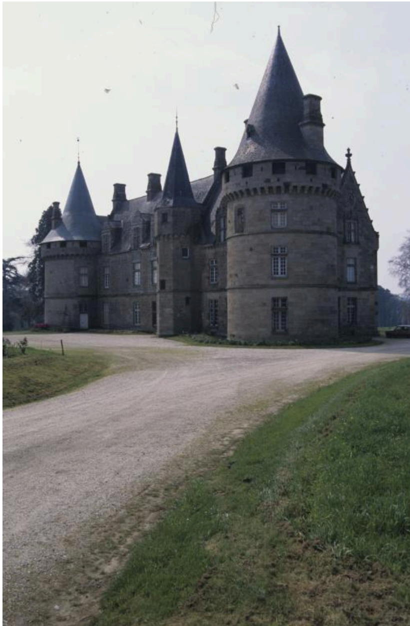
Vue générale prise du nord-est.
