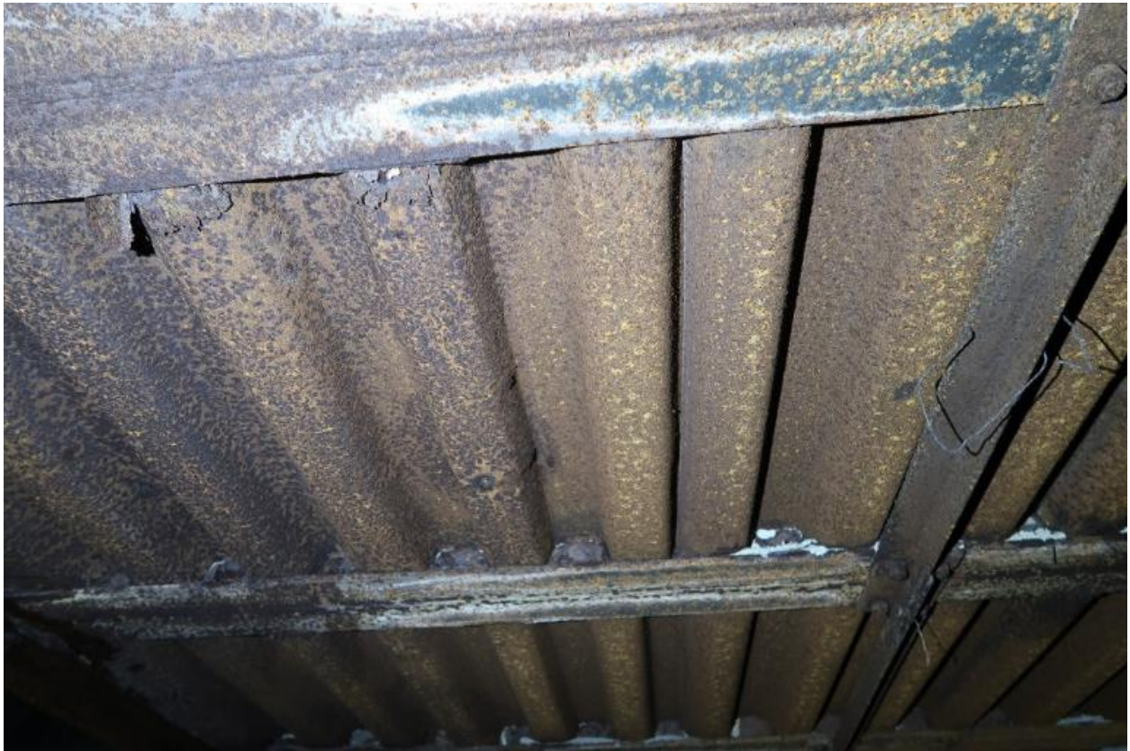
Vue de l'extension nord-ouest : détail du dessous de la dalle de couverture du bunker Keroman III, plaques nervurées
