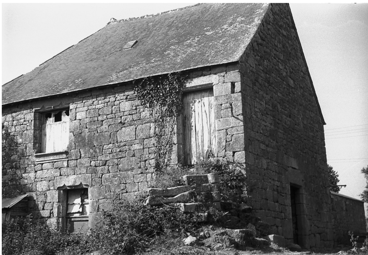
Bâtiment au sud (porcherie) : vue de situation prise du sud est
