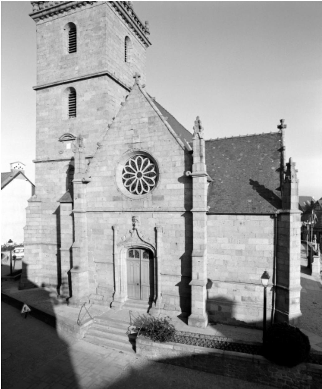
Elévation Ouest : vue générale
