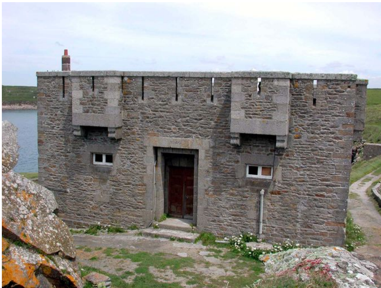
Vue du réduit de batterie de côte de la pointe de Kermorvan, façade occidentale, l'entrée
