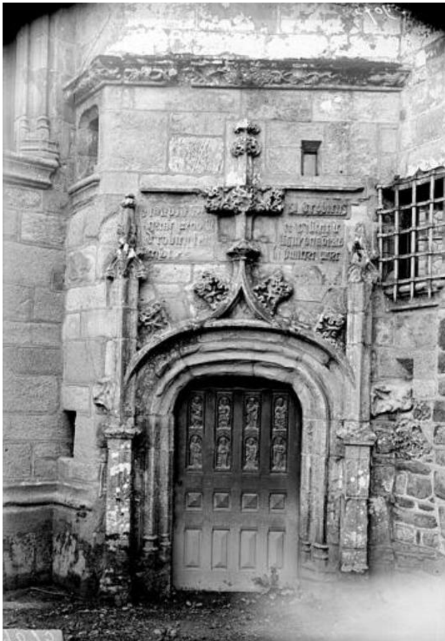
Château, tourelle d'escalier : la porte (état en 1921)
