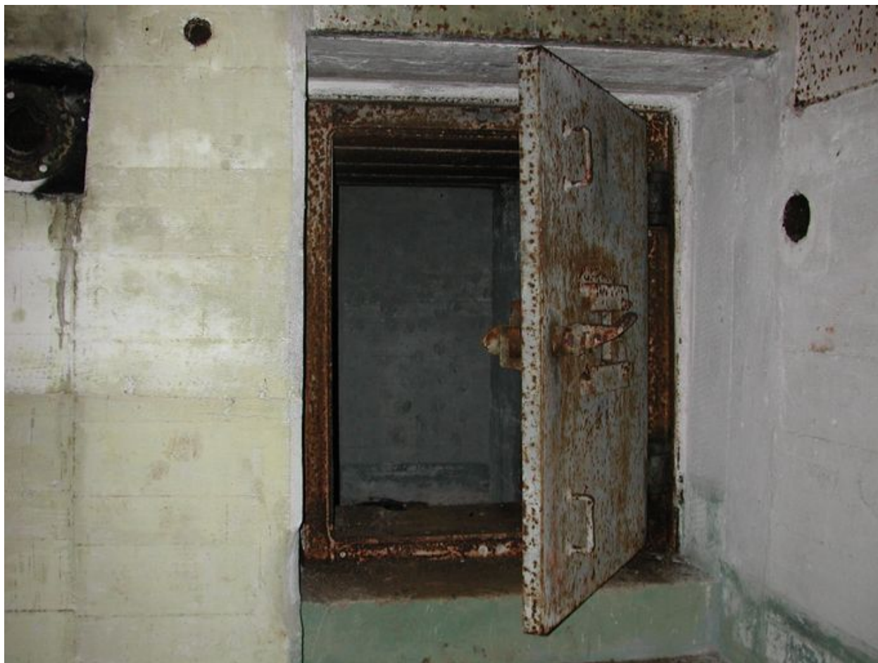
Vue intérieure : porte blindée (état en 2002)
