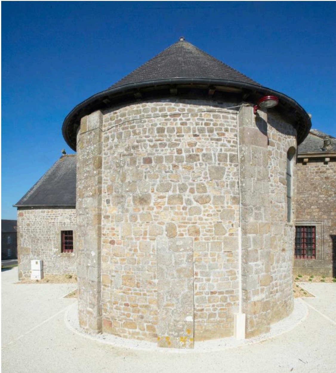
Elévation Est, le choeur : vue générale
