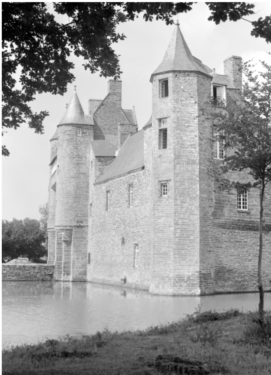
Château vu du sud-est (état en 1986)
