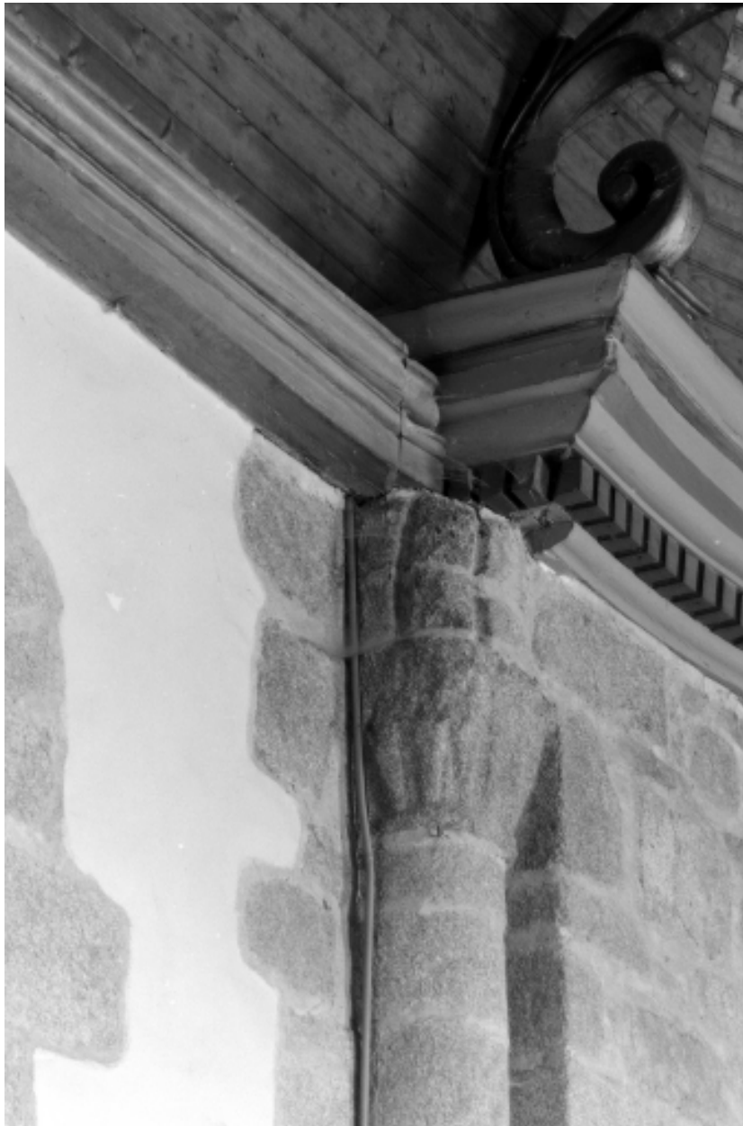
Intérieur, chœur, mur nord : détail d'un chapiteau.
