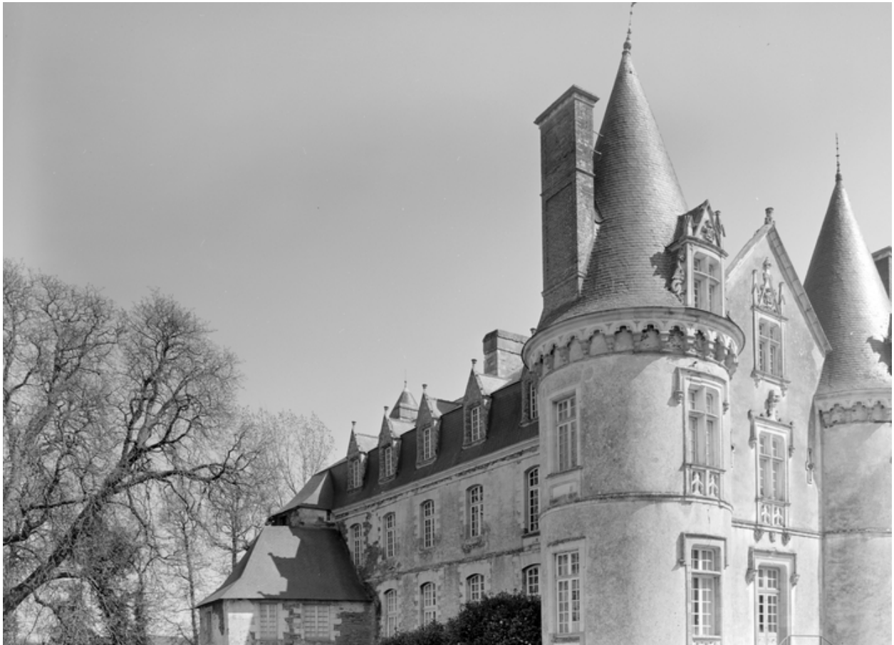
Château, logis : vue générale prise du nord-ouest (état en 1984)
