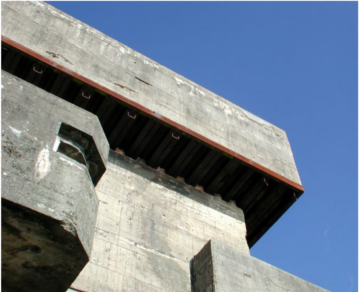
Vue de la base de sous-marins : front sud-ouest, détail de la casemate de défense de l'entrée ouest (2004)
