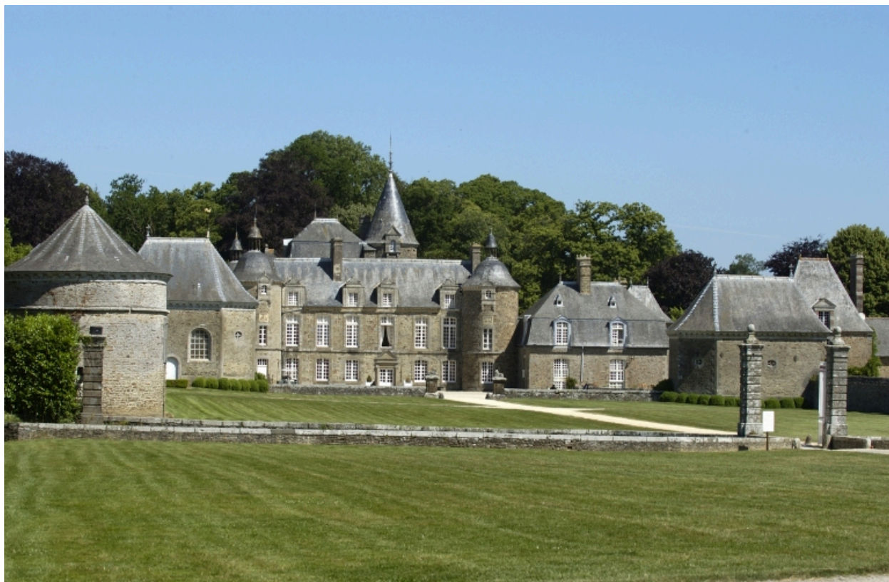
Vue générale sud
