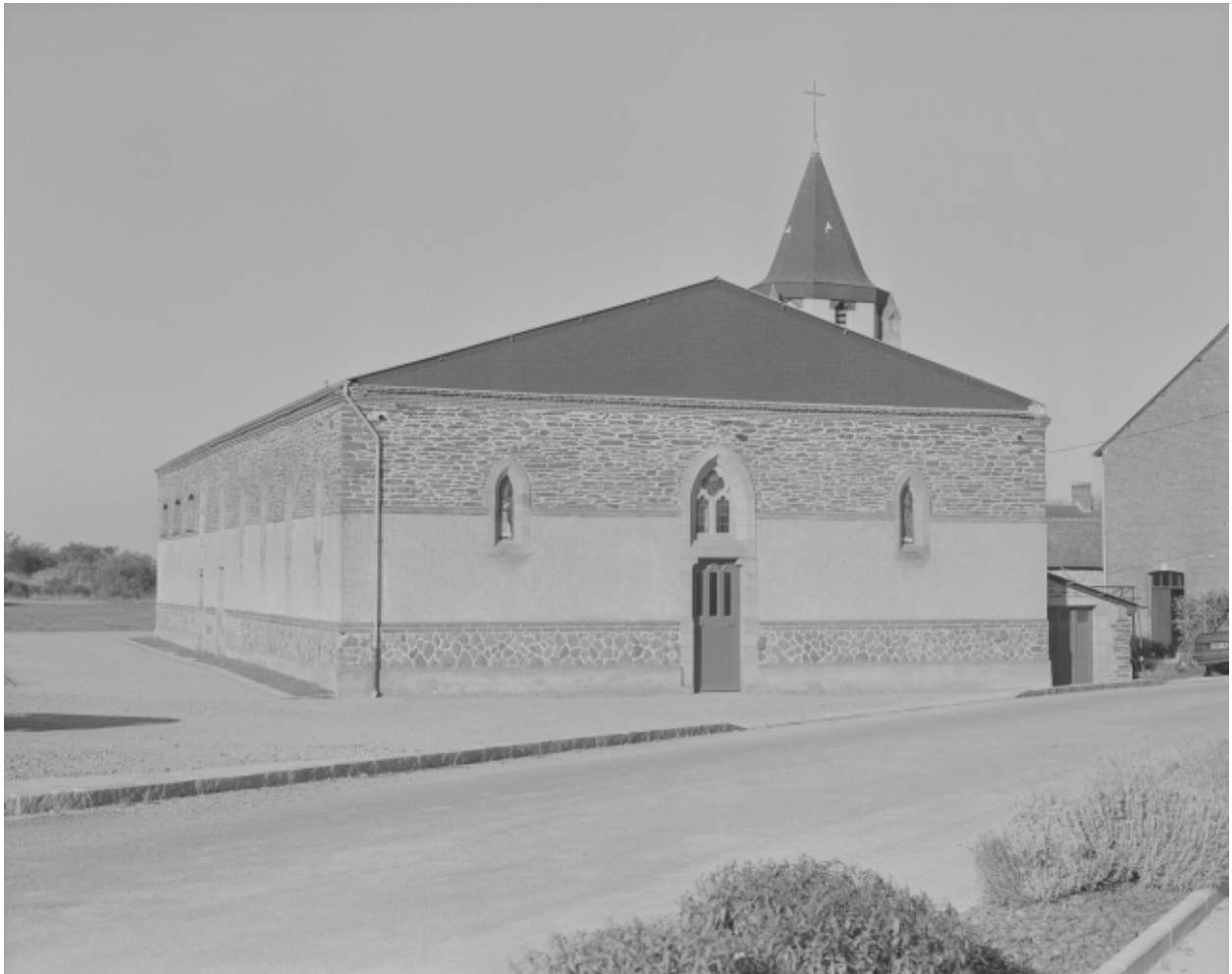
Elévation est : vue générale
