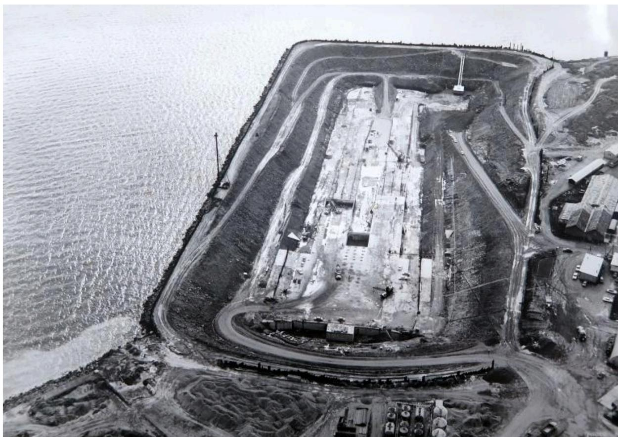
Travaux de construction de la forme 2 : mise en œuvre du radier ; forage pour ancrage en cours (10/1965)
