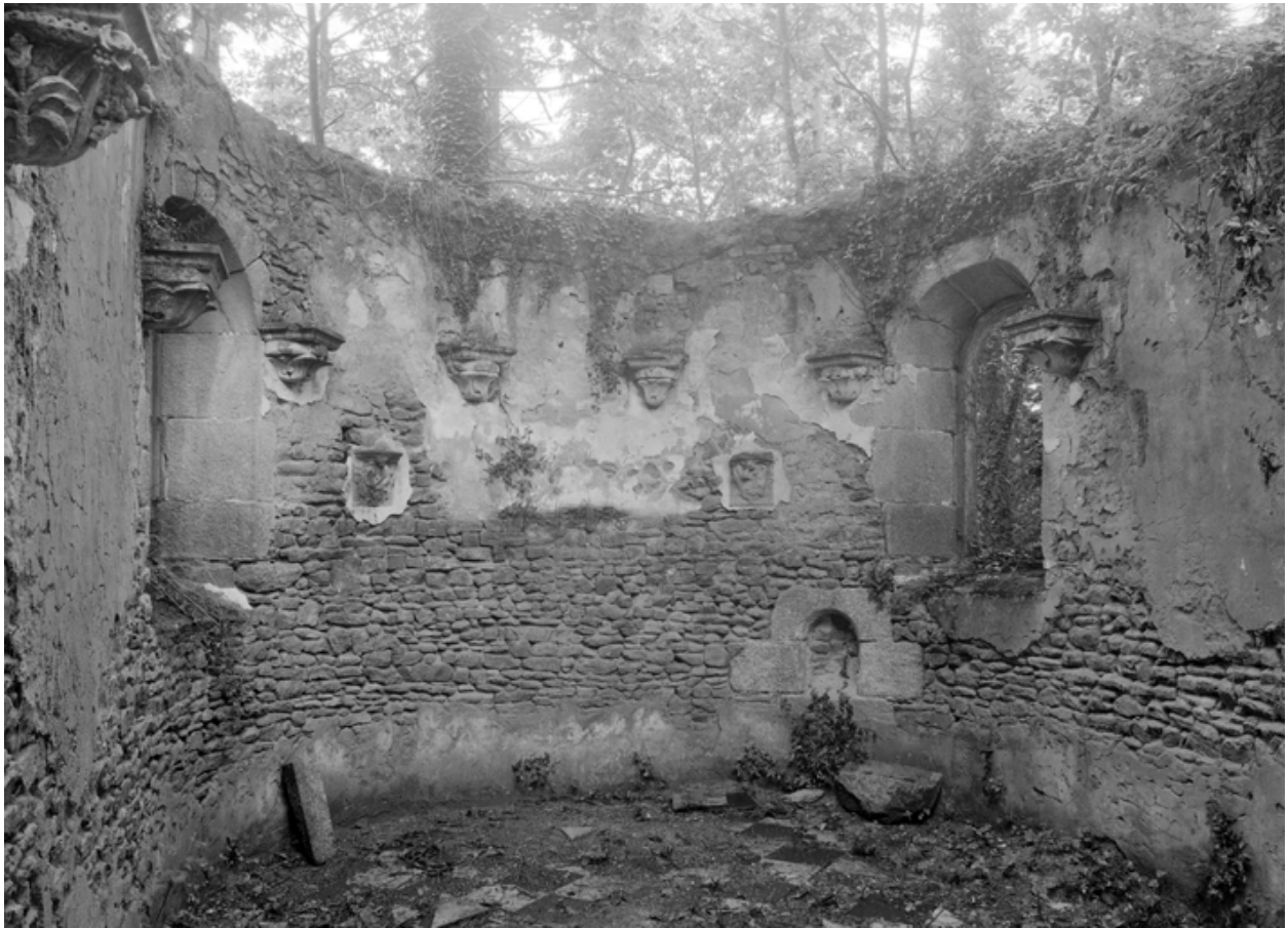
Chapelle : vue intérieure.
