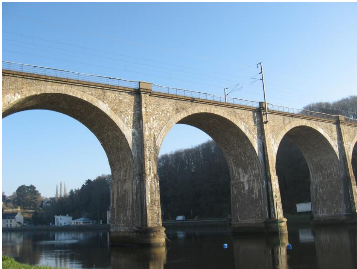
Le viaduc, vue de l'aval
