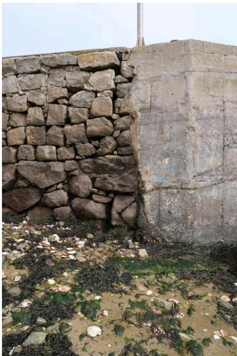
Cale de Porz Kernog, détail de la mise en oeuvre : mise en oeuvre pierres-sèches et béton
