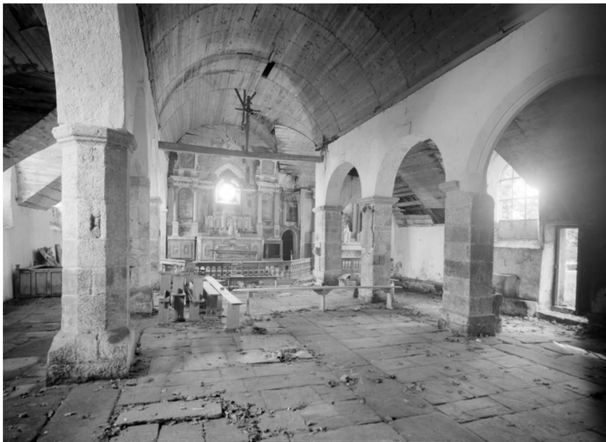
Vue générale d'ouest en est
