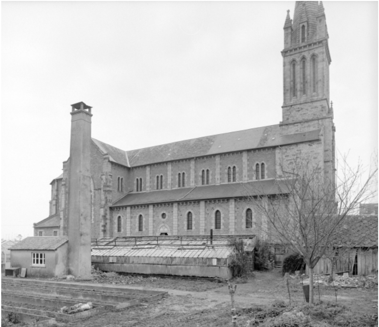
Elévation Sud-Est : vue générale
