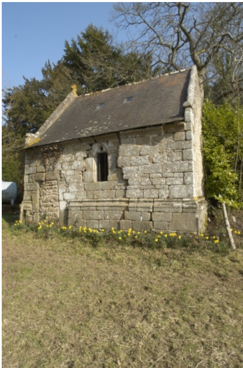
Mur sud de la chapelle
