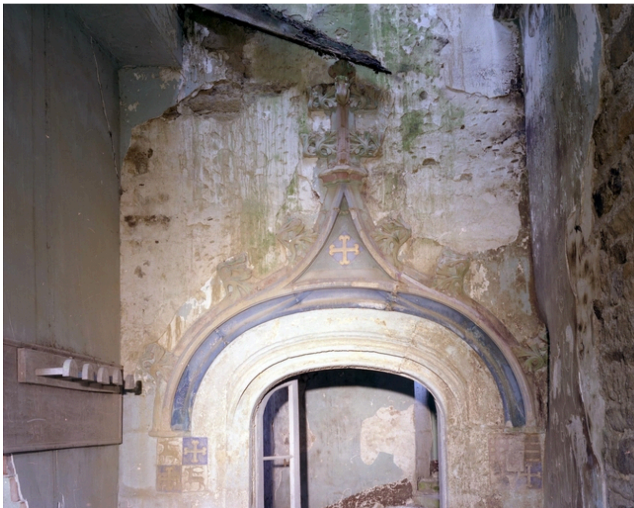
Intérieur, rez-de-chaussée, porte d'accès à l'escalier : détail de l'archivolte.
