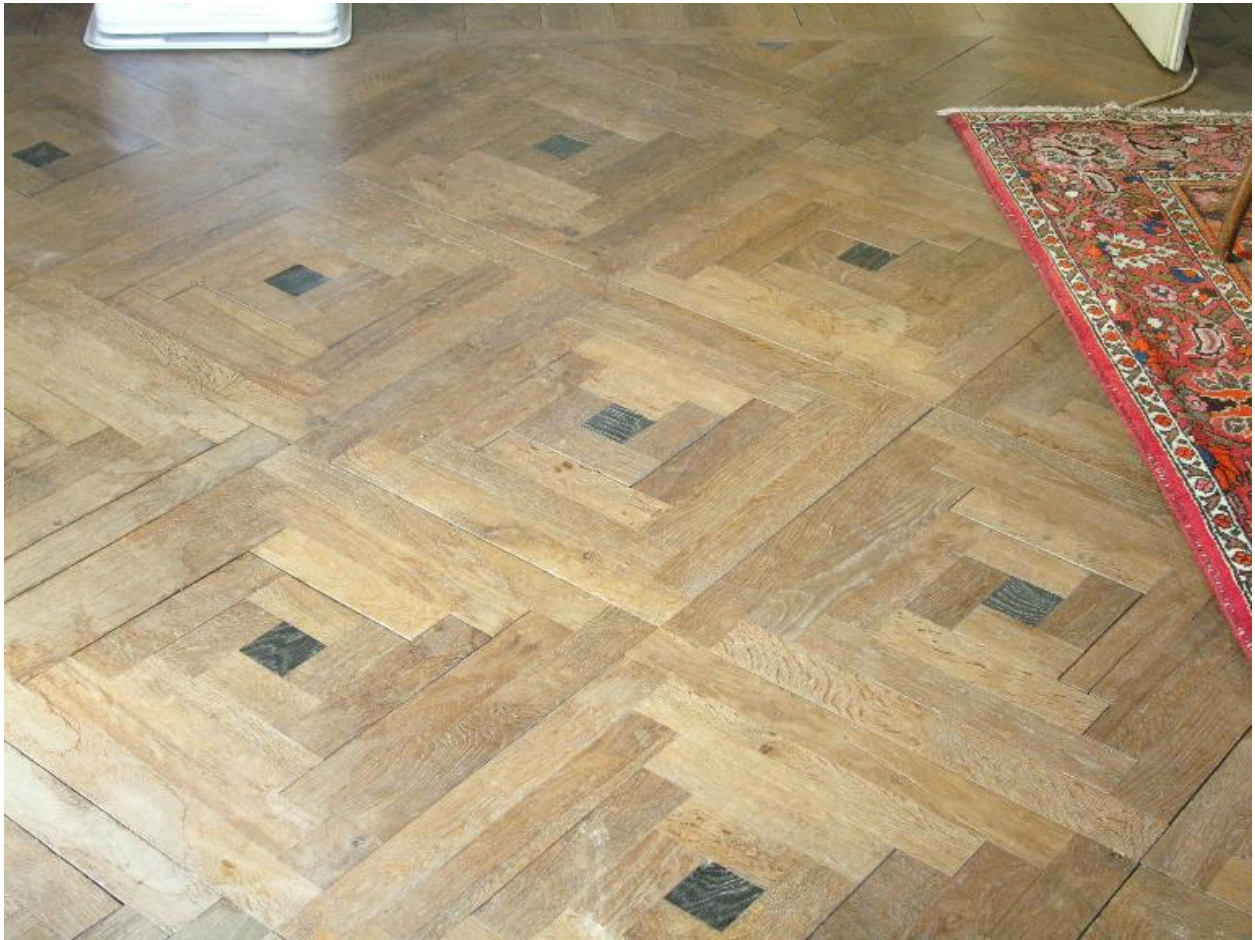
Détail du parquet
