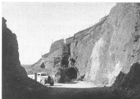
Entrée du Portzic (mars 1943). Entrée du souterrain vue de la route d'accès.
