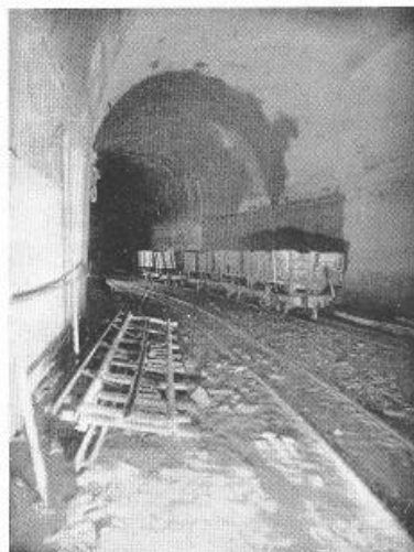
Entrée du Portzic. Grille d'accès. Vue prise vers le pont du souterrain.
