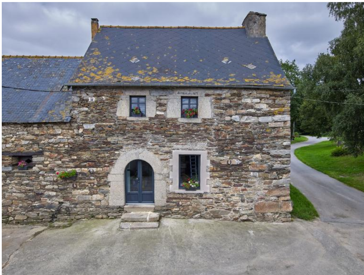
Logis 1673. Vue générale sud
