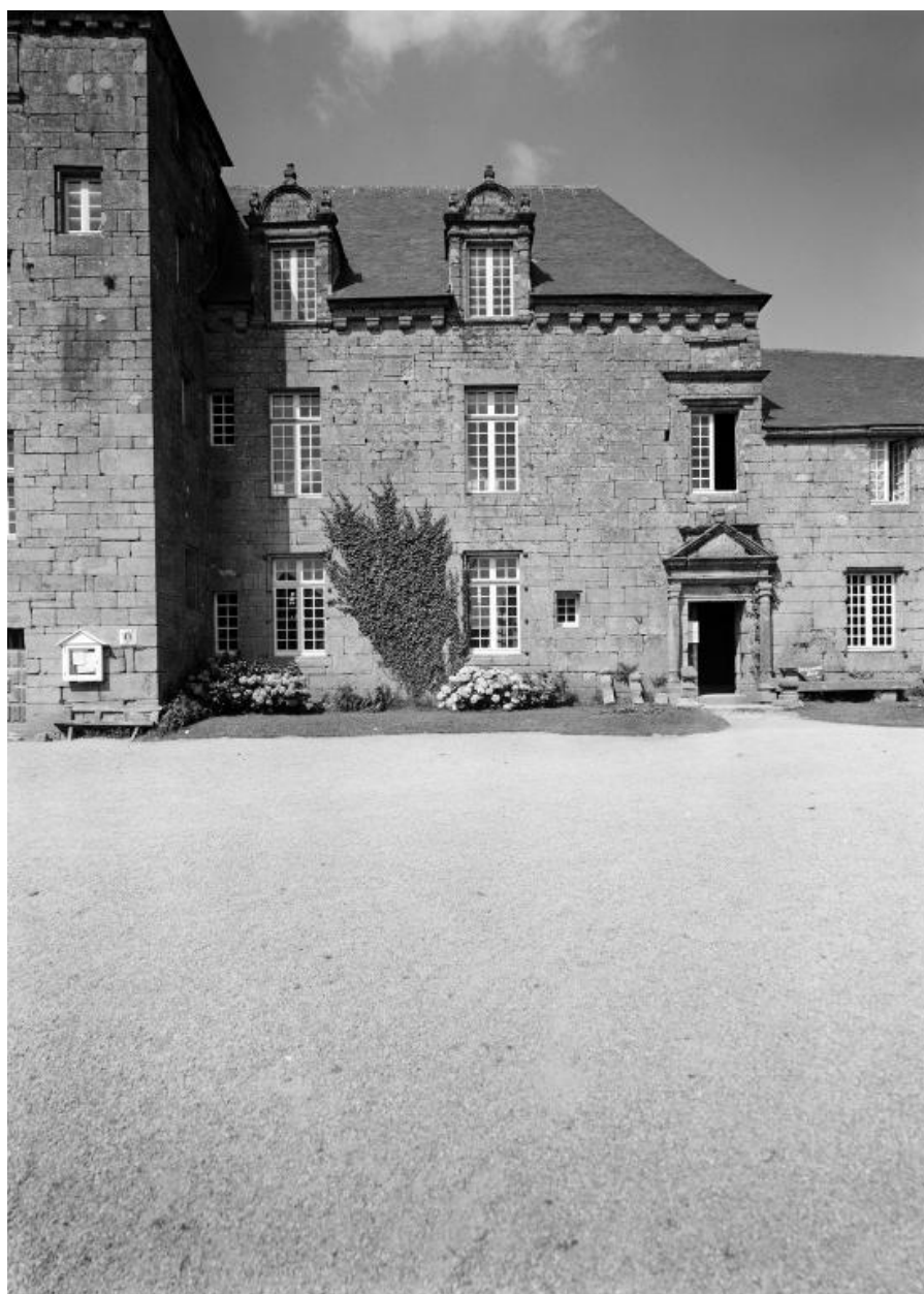
Vue d'ensemble façade sud de la partie centrale
