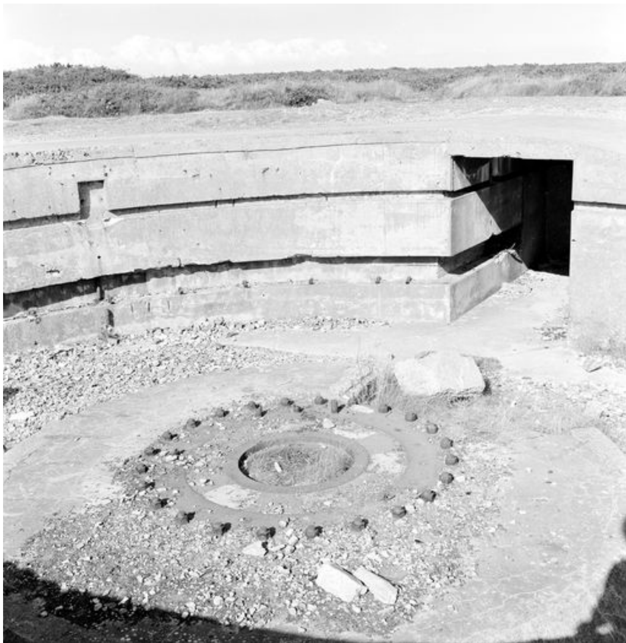
Vue de l'une des quatres cuves à canon (état en 1969)
