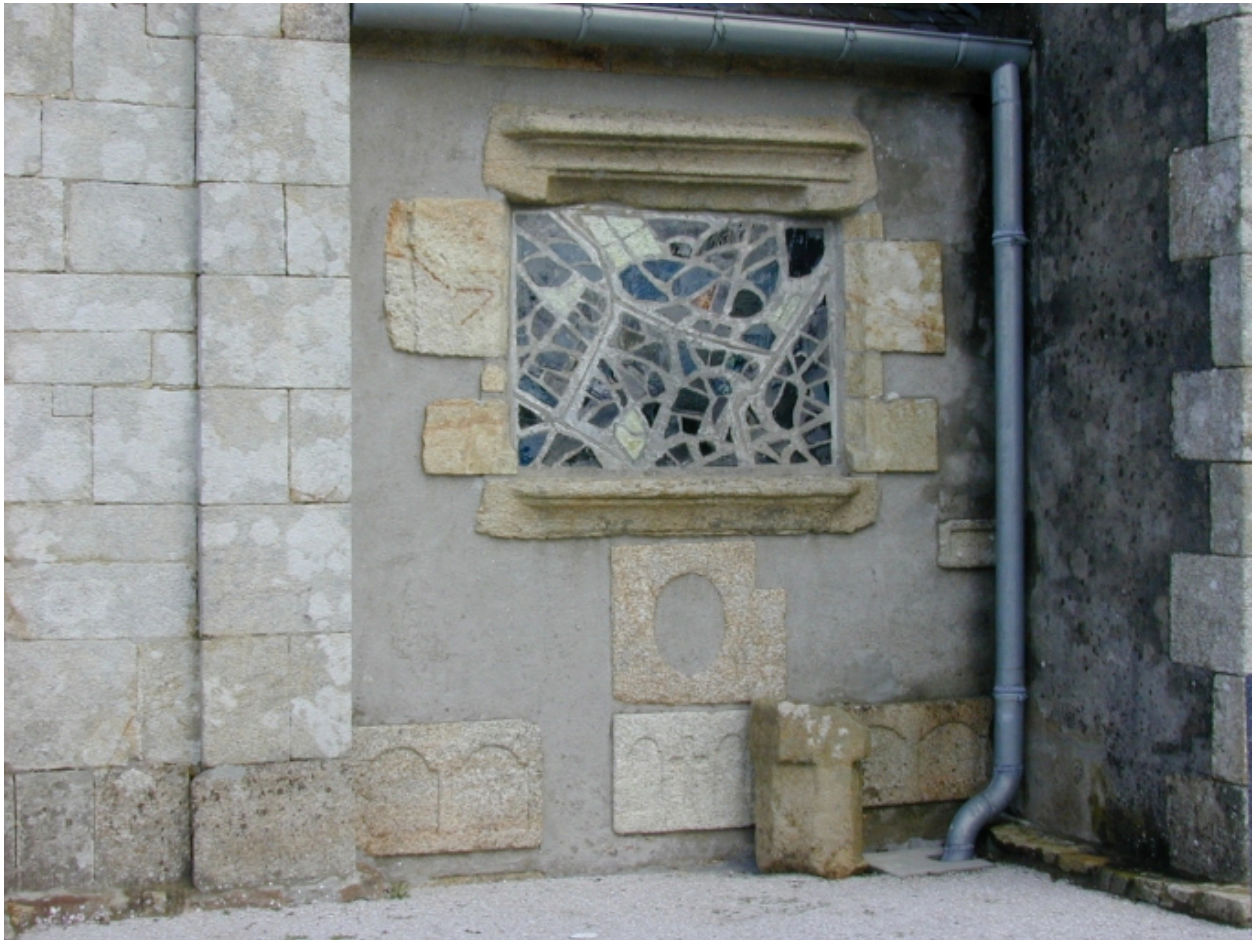
Baye, église paroissiale Saint-Pierre-aux-Liens : élévation sud, chapelle des fonts baptismaux, détail des éléments remployés, état en 2003
