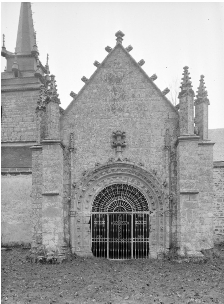
Vue d'ensemble du porche sud.
