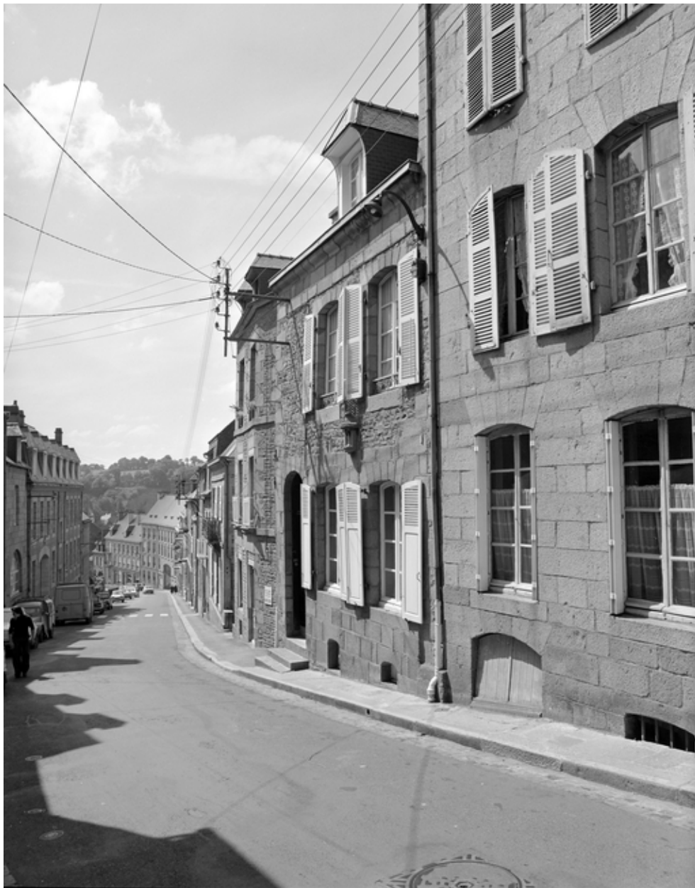
52 rue de la Pinterie, vue générale sud-est.
