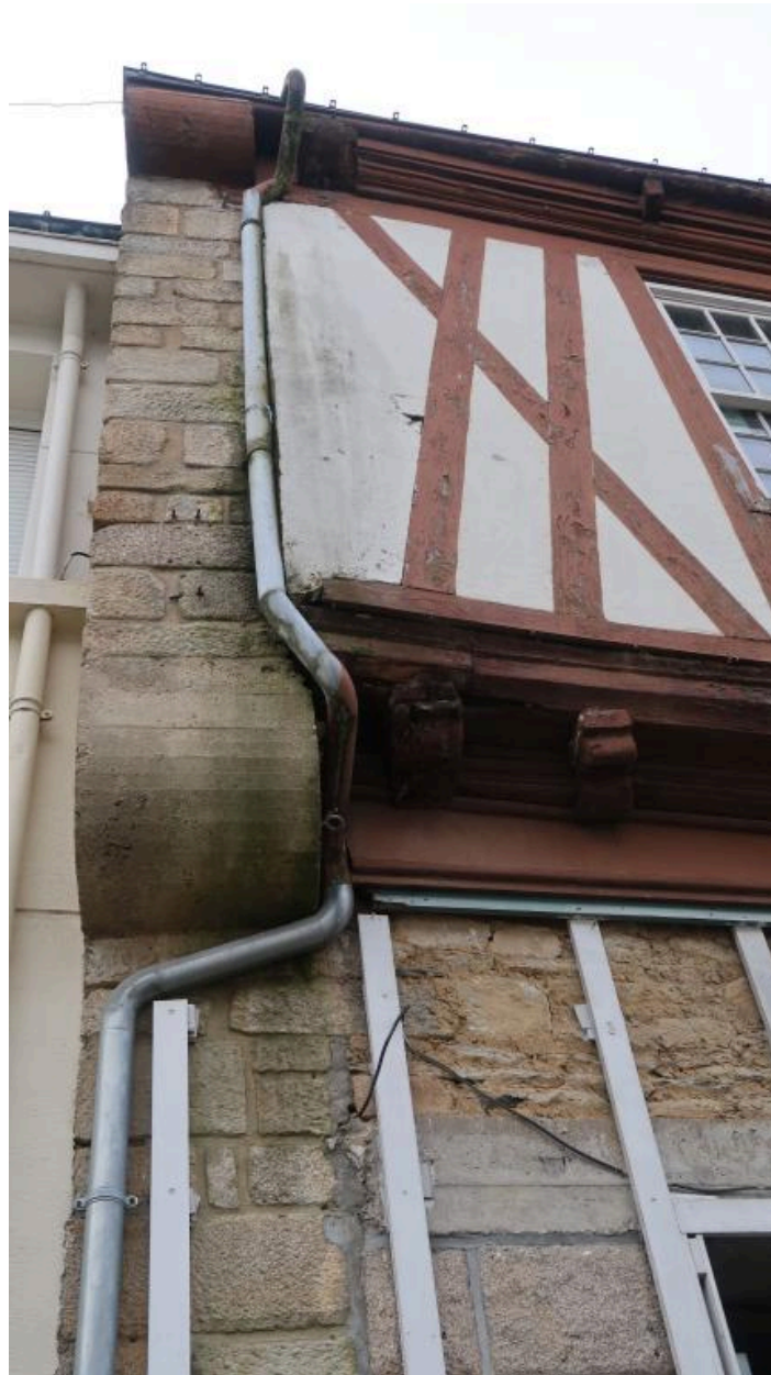
Vue rapprochée du mur en encorbellement et des modifications (état 2019)
