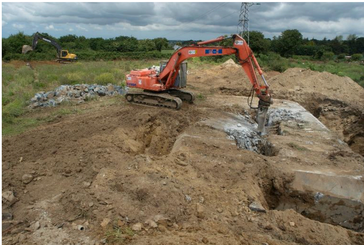
Déconstruction d'un bunker de type 502
